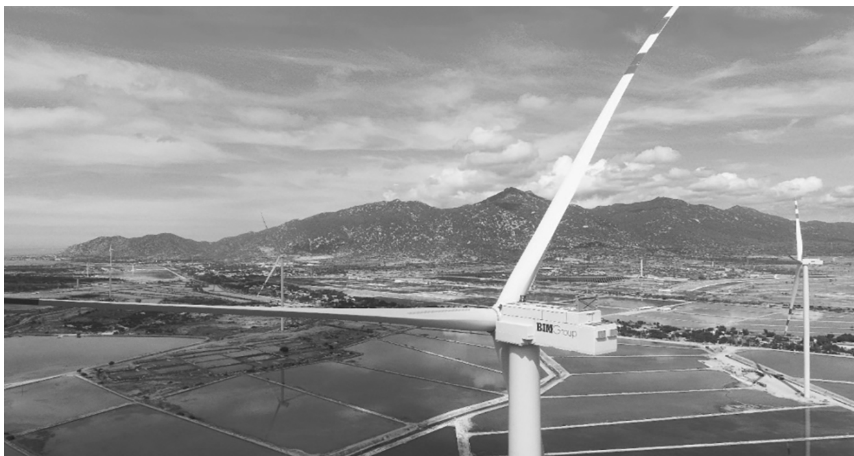
Hình 1. Dự án Điện gió BIM Ninh Thuận
